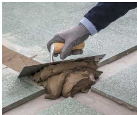
Füllen von Aussparungen mit Planipatch Xtra
